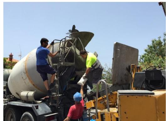
*Figs.-12- 13-14 Obra. Aditivado del hormigón. Fuente: Clauni Canarias, SL*
